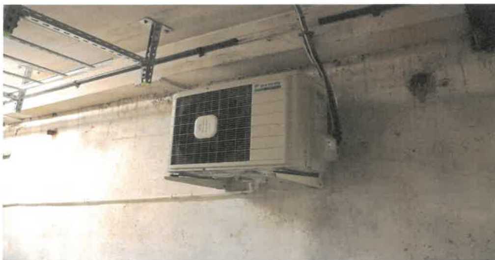
zdj. 2 Jednostka zewnętrzna w korytarzu kablowym.
